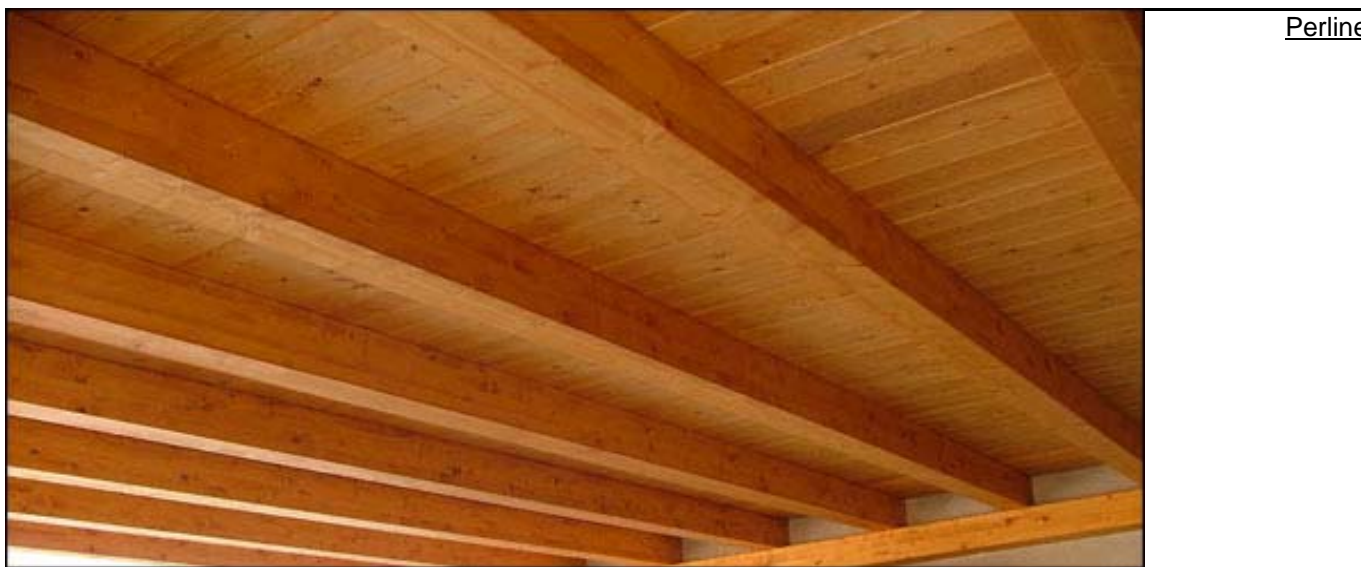
Particolare realizzazione tetto con perline impregnate.
