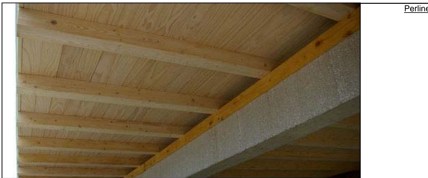
Particolare realizzazione tetto con perline.
