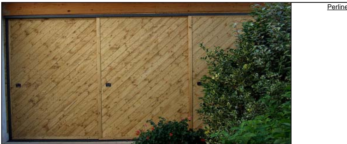
Particolare realizzazione porte scorrevoli con perline impregnate.
